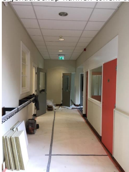
Nieuwe plafondplaten, nieuwe verf op de muren, kozijnen en deuren
